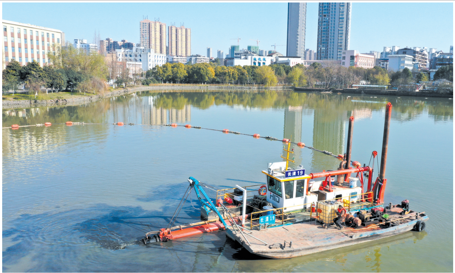
近日,工人在沙市区张李家洲湖进行抽淤泥作业。张李家洲清淤项目于去年5月启动,已累计清除淤泥5.27万立方米,整个工程预计春节后完工。清淤完工后,相关部门还将对该湖泊进行水生生态恢复,通过种植绿色水植物和放养水生生物等方式恢复水系的自我净化能力。(记者 梅闻 摄)
