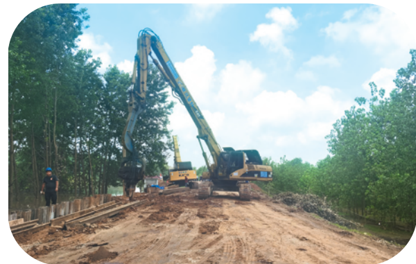
石首采取打钢板墙护堤等举措,成功处置重大险情,创造了石首经验。
