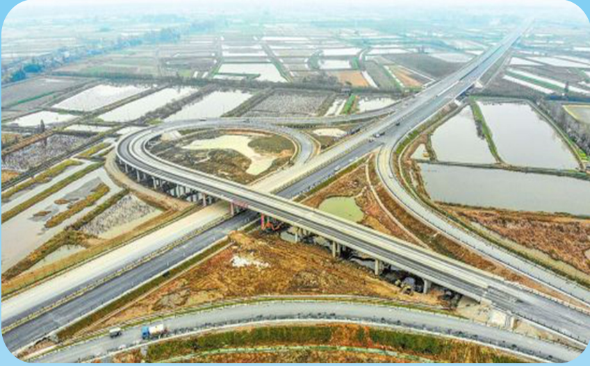
江北高速公路东延线项目正在加紧建设
