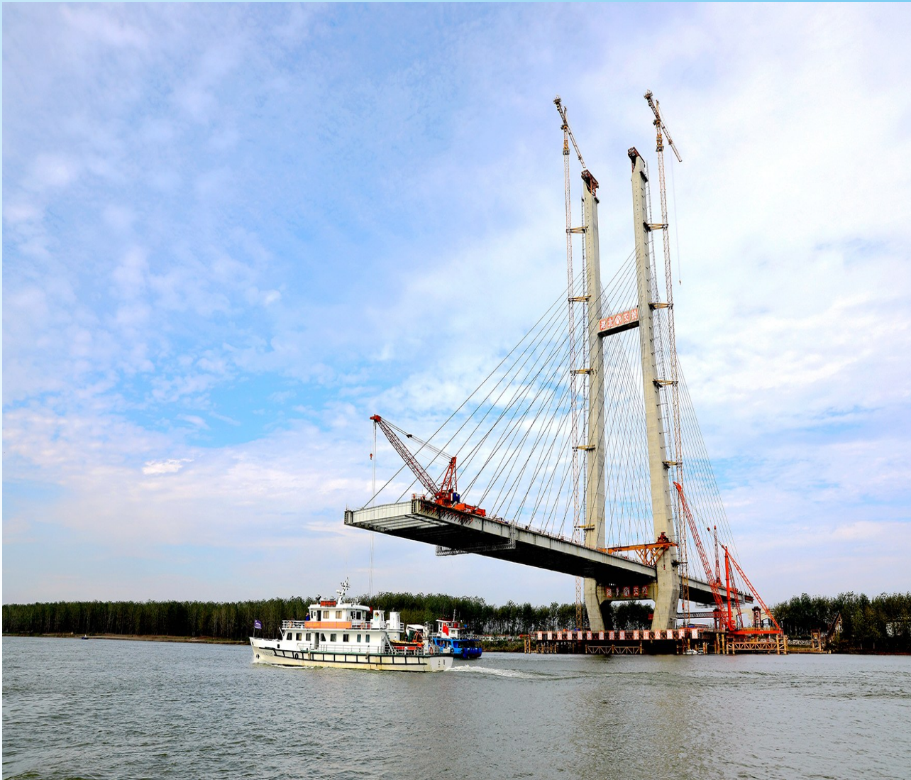
洪湖至赤壁长江大桥即将完工
