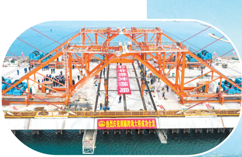
1月25日，工人在湛江调顺跨海大桥合龙施工现场作业。当日，由中铁大桥局承建的湛江调顺跨海大桥成功合龙。全长约9.36公里的调顺跨海大桥为广东省重点工程，跨越湛江湾连接江市区调顺岛及海东新区，将对接粤港澳大湾区，对加快广东粤西片区经济发展发挥重要支撑作用。（新华社发）
