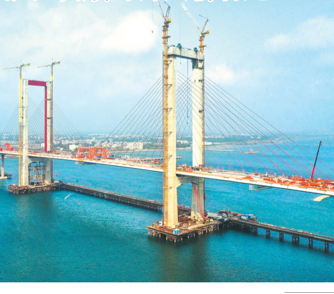
1月25日，工人在湛江调顺跨海大桥合龙施工现场作业。当日，由中铁大桥局承建的湛江调顺跨海大桥成功合龙。全长约9.36公里的调顺跨海大桥为广东省重点工程，跨越湛江湾连接江市区调顺岛及海东新区，将对接粤港澳大湾区，对加快广东粤西片区经济发展发挥重要支撑作用。（新华社发）
