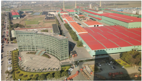
湖北亿钧耀能新材股份公司 提供1000多个就业岗位 新项目可实现产值100亿元
