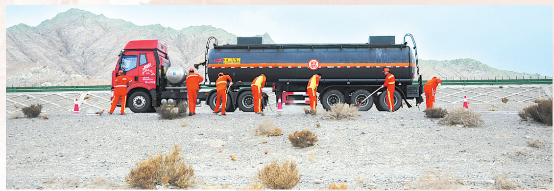
格尔木公路段养路工人正在进行养路作业。(新华社发)
