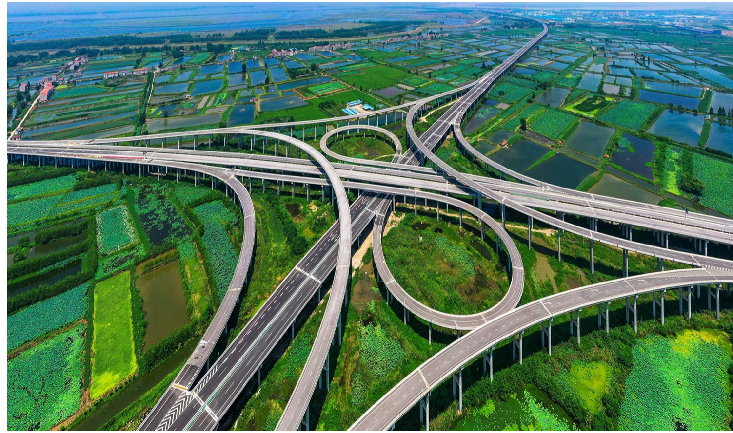
洪监高速与武汉外环高速互通枢纽
