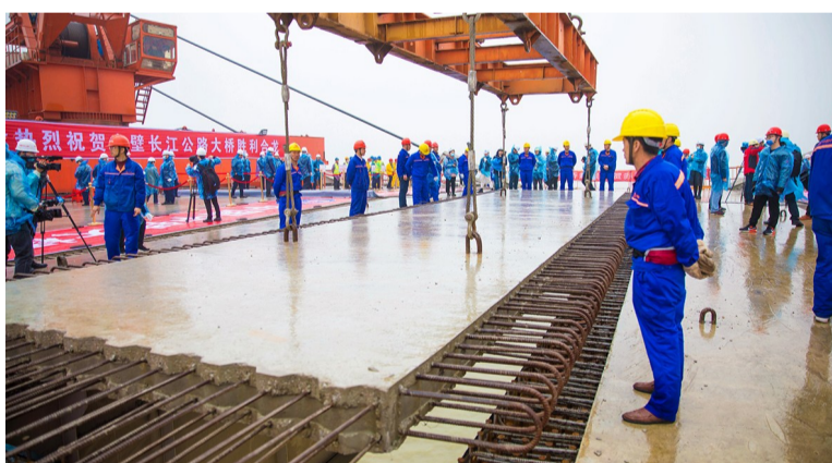
吊装最后一块钢梁
