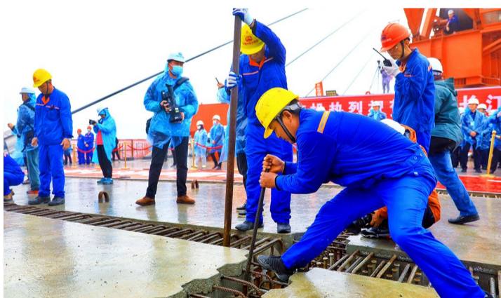
工人们将最后一块钢梁衔接到位
