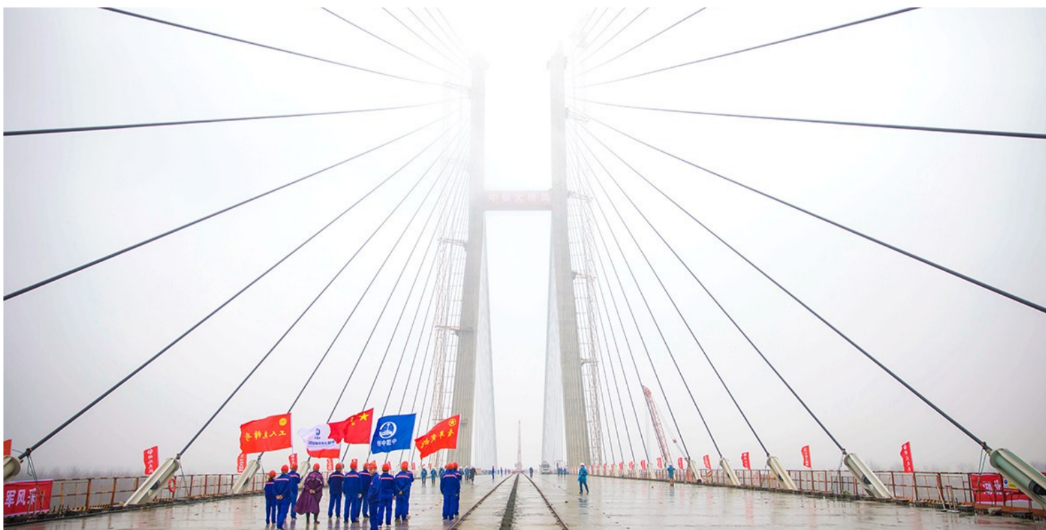
合龙后的洪湖至赤壁长江大桥
