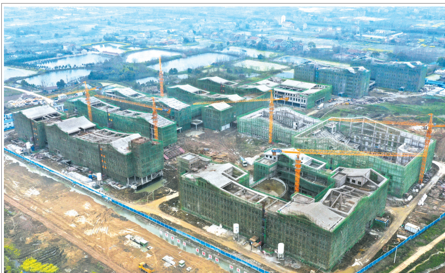
昨日,无人机俯瞰荆州北门中学新校区。新校区占地面积184.91亩,建筑面积8.92万平方米,设计教学班60个,整个校舍可容纳3000人,共有教室、校舍12栋,初步规划6月底全面完工。(记者 梅闻 通讯员 范代诚 摄)
