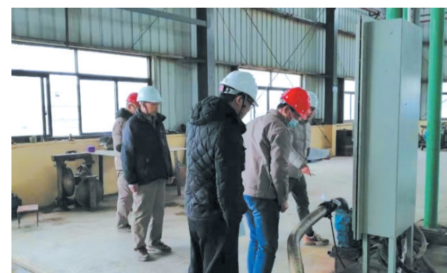
近日,县应急管理局聘请荆州市专家化工领域专家,对园区正在生产的11家化工企业开展隐患排查,共发现安全隐患98处,现场下达限期整改通知,全力压降企业安全风险,打造本质安全型产业园区。(杨帆 摄)
