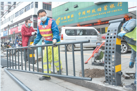
近日,施工人员在沙市区北三小附近安装新型人行道隔离护栏。(记者 潘路 摄)
