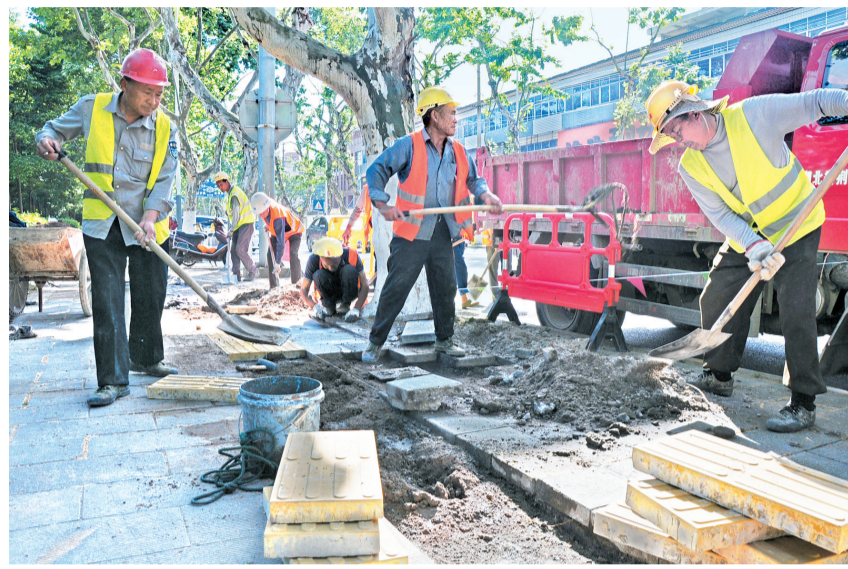
近日,施工人员对沙市区白公路沿线人行道进行提升改造。为方便市民出行,提升城市整体形象,今年,我市结合相关创建工作要求,对中心城区人行道进行升级改造。(记者 潘路 摄)
