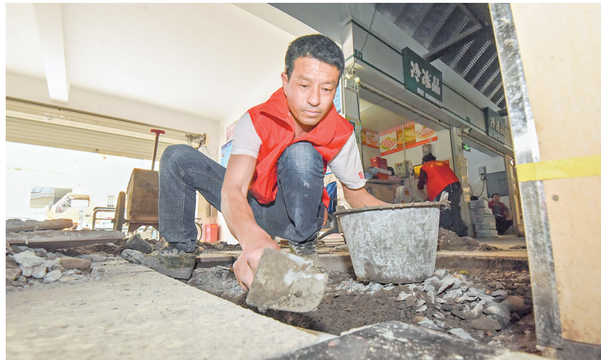
5月11日,施工人员在荆州区新风菜市场进行施工作业。连日来,我市中心城区的38个农贸市场(菜市场)陆续进行达标升级改造。 (记者 黄志刚 见习生 张梦瑶 摄)
