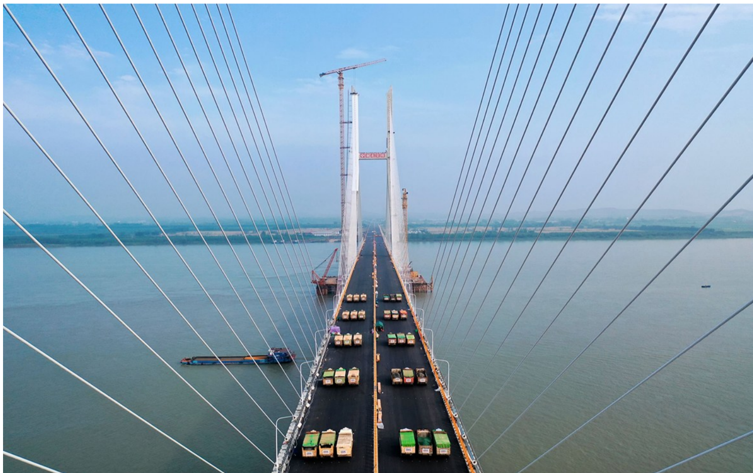
洪湖至赤壁长江公路大桥荷载试验现场。(通讯员 黄茹摄)
