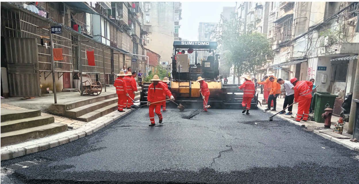
为提升社区居民的居住环境,沙市区加快推进老旧小区改造工作进度。这是施工人员对胜利街道王板桥社区10000平方米路面进行刷黑升级,相关改造有效改善了老旧小区道路环境。(吴秋璇 摄)
