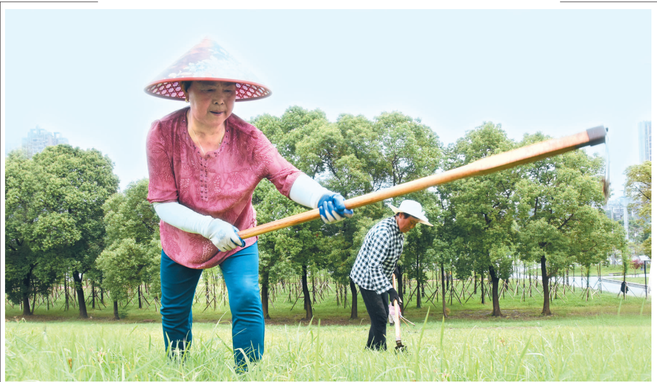
5月27日,在荆江大堤沙市区临江仙公园段,工人们正在锄草,确保汛期堤防安全,进一步提升堤容堤貌。
