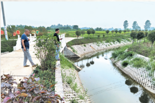
修缮一新的水渠。
