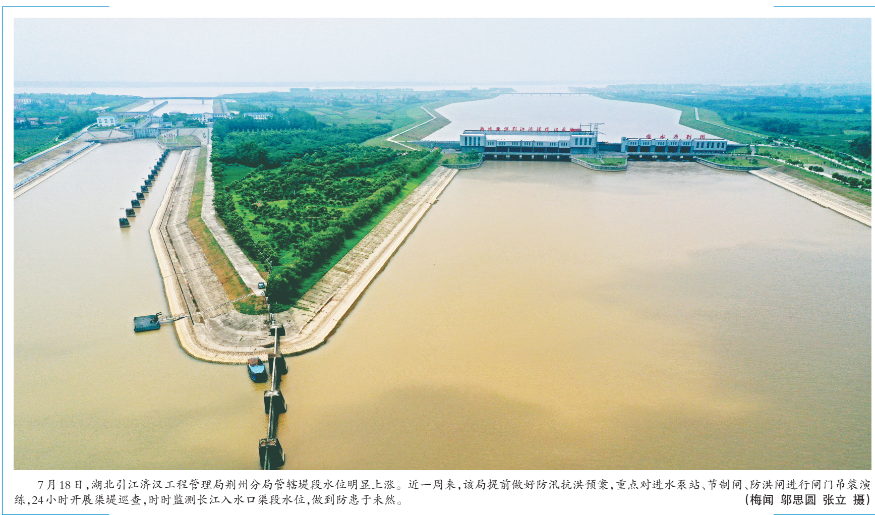
7月18日,湖北引江济汉工程管理局荆州分局管辖堤段水位明显上涨。近一周来,该局提前做好防汛抗洪预案,重点对进水泵站、节制闸、防洪闸进行闸门吊装演练,24小时开展渠堤巡查,时时监测长江入水口渠段水位,做到防患于未然。(梅闻 郭恩圆 张立 摄)
