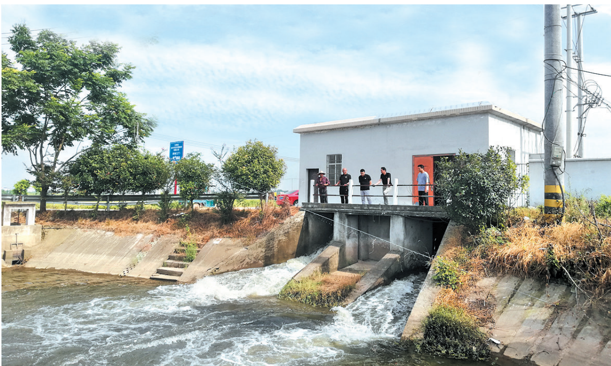
近日,泰市乡以防汛物资储备、泵站、涵闸、渠堤等为重点,全面检查防汛抗旱工作,现场检查重要机电泵站运行情况,查看主要灌排渠道低矮段面、险工险段和脱坡整险加固地段,确保重要水利工程设施防洪安全和人民生命财产安全。(齐彩文 摄)
