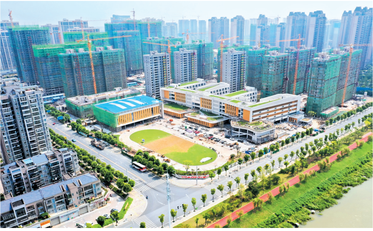
位于荆北新区的荆州实验中学荆北校区,目前已经完成80%以上的工程量,可以在8月中旬全部竣工,9月1日按期开学。项目总建筑面积2.6万平方米,规划用地面积约36亩,总投资1.2亿元,建有教学楼、游泳馆、报告厅、图书馆、体育馆、餐厅等。(李文健 摄)
