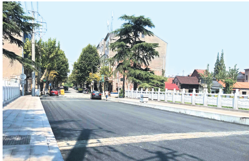
近日,郝穴镇西湖路红卫桥、永济路竣工通车,改善了沿线居民出行条件,提高了城市路网通达性。(熊海燕 摄)
