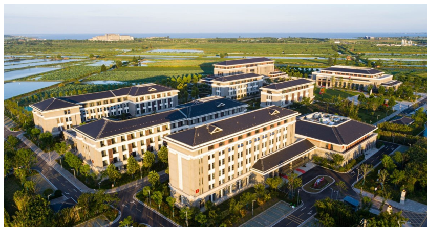
洪湖市委党校7栋主体建筑
