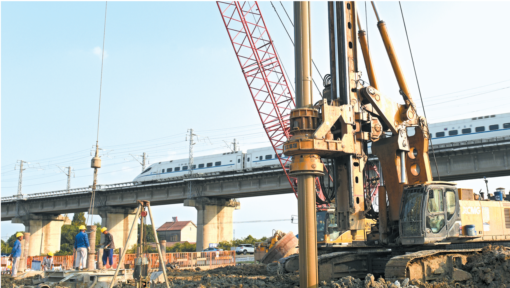
9月12日下午,在荆荆铁路4标段3工区荆州市境内江汉运河特大桥施工现场,中铁十二局集团公司施工人员精心作业,一片热火朝天景象。荆荆铁路4标段线路跨越G50沪渝高速、318国道、江汉运河及汉宜铁路,全长12.199公里,投资17.3亿元,采用连续梁拱桥跨越江汉运河,是全线的控制性工程。目前,桥梁工程桩基完成527根,承台完成3座,路基工程路基清表完成1.2万平方米,地基处理桩正在进行工艺性试验。 (记者 叶力铭 摄)
