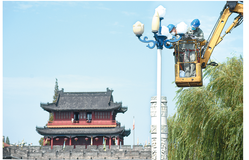
9月13日,市路灯管理服务中心工作人员正在检修维护金凤广场上的路灯。中秋、国庆两节临近,市路灯管理服务中心近期对中心城区路灯进行全面的检修维护。(记者 潘路 摄)
