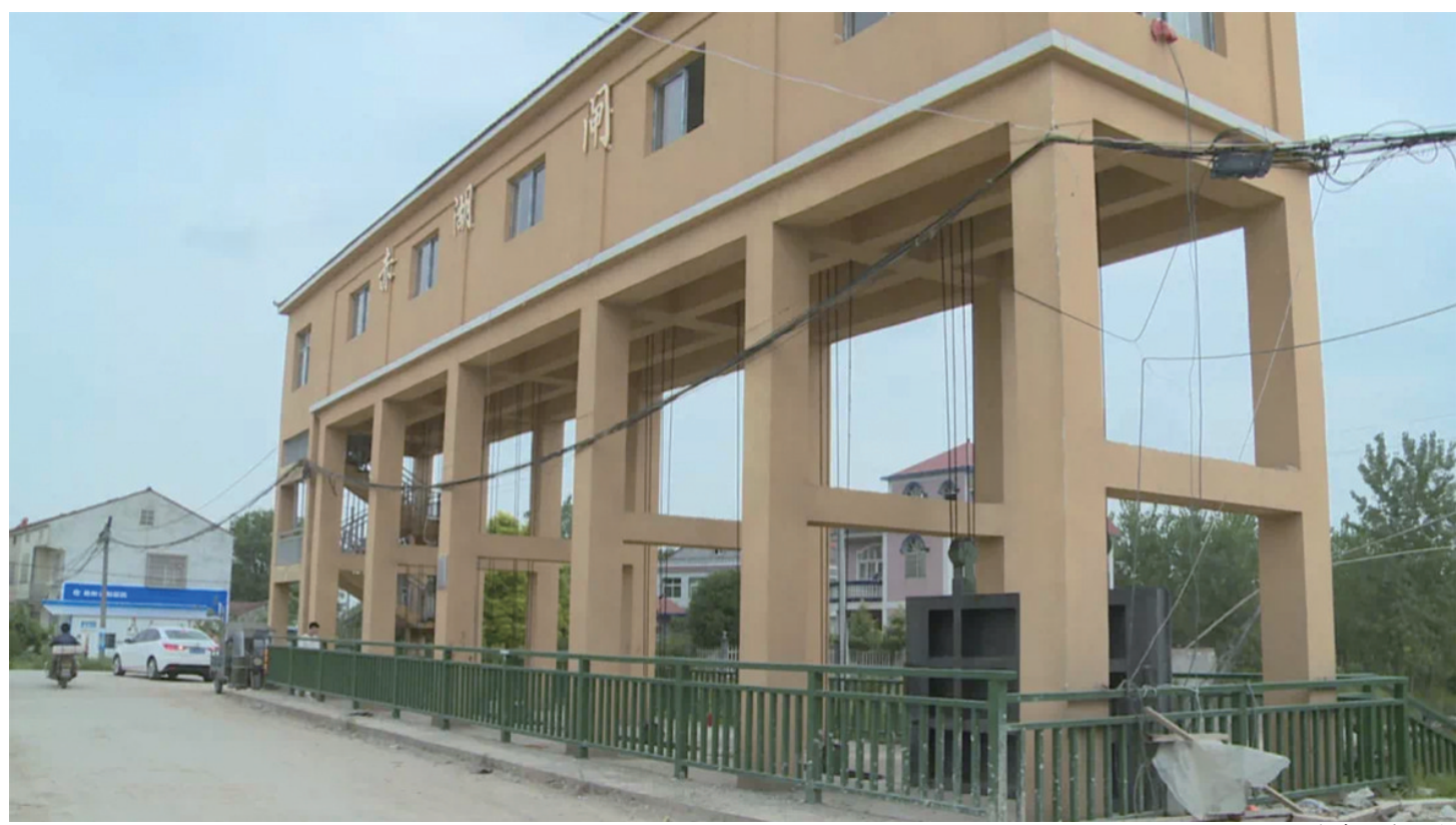
改造后的泵站
