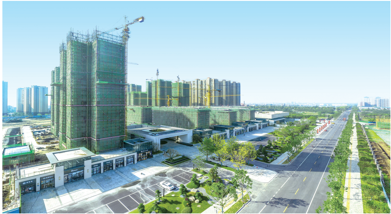
火热建设中的楚天都市·润园
