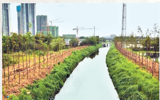
荆安渠渠道投入使用。
