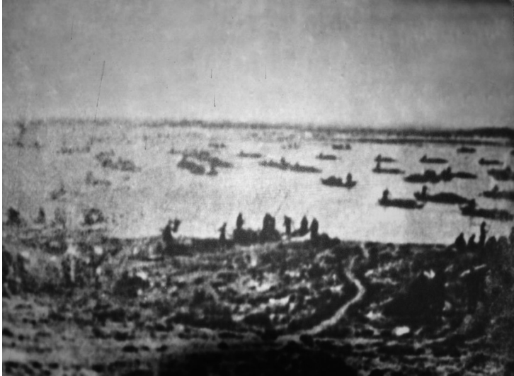
1932年，路易·艾黎拍摄的洪湖苏区群众抢修堤防的情景。
