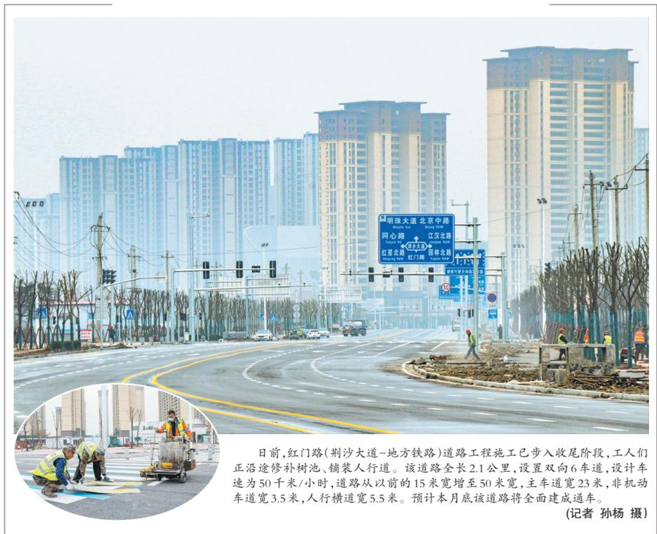
日前,红门路(荆沙大道—地方铁路)道路工程施工已步入收尾阶段,工人们正沿途修补树池、铺装人行道。该道路全长2.1公里,设置双向6车道,设计车速为50千米/小时,道路从以前的15米宽增至50米宽,主车道宽23米,非机动车道宽3.5米,人行横道宽5.5米。预计本月底该道路将全面建成通车。(记者 孙杨 摄)
