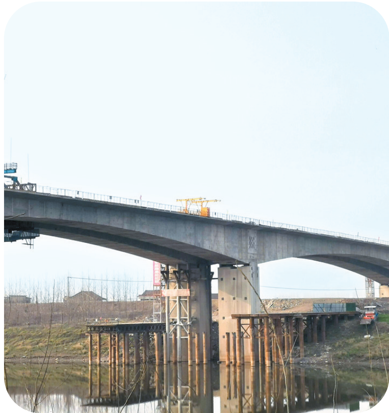
G207公安县埠河至南平段改建工程现场。
