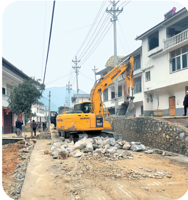
恩施市红色文化旅游产业循环路施工现场。
