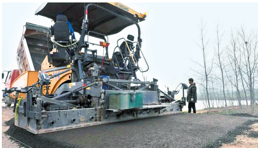
日前,马家寨乡长江村耀新彩虹公路修建项目建设正酣,已完成工程量的55%。(覃正刚 摄)
