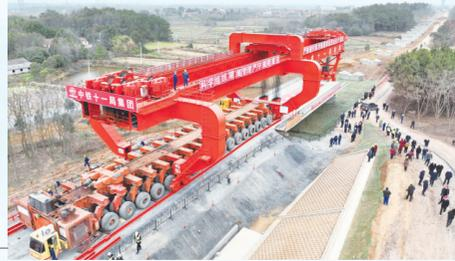
3月1日,荆荆高铁1标首榀箱梁平稳架设在桥墩上。
