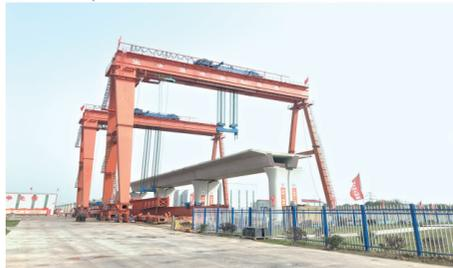
荆荆铁路项目施工现场,提梁机正将箱梁缓缓放到桥墩上。
