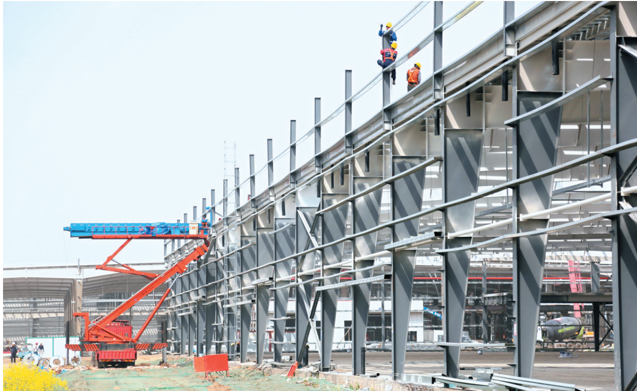
3月15日,位于荆州开发区的湖北美的洗衣机产业园建设现场,工人正抢抓工期加快建设。(记者 潘路 张梦瑶 摄)
