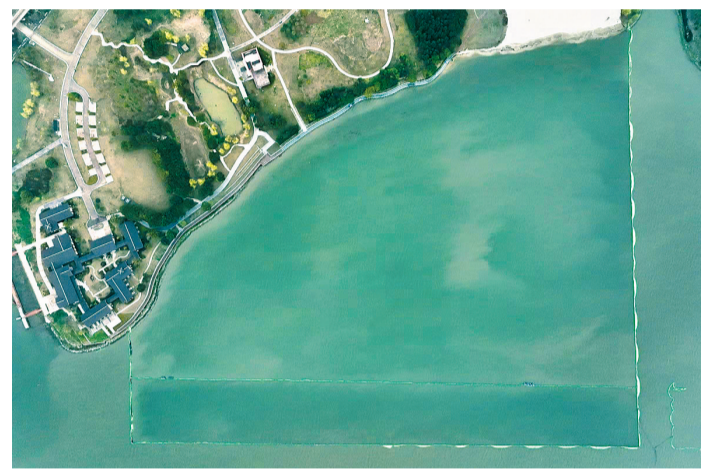
无人机俯瞰长湖庙湖湾荆州市长湖水生态修复工程现场。
