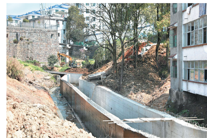
恩施市玉龙河黑臭水体整治工程现场。
