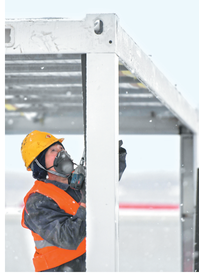
3月15日,工人在吉林市高新南区隔离方舱项目施工现场组装隔离方舱箱体。(新华社发)
