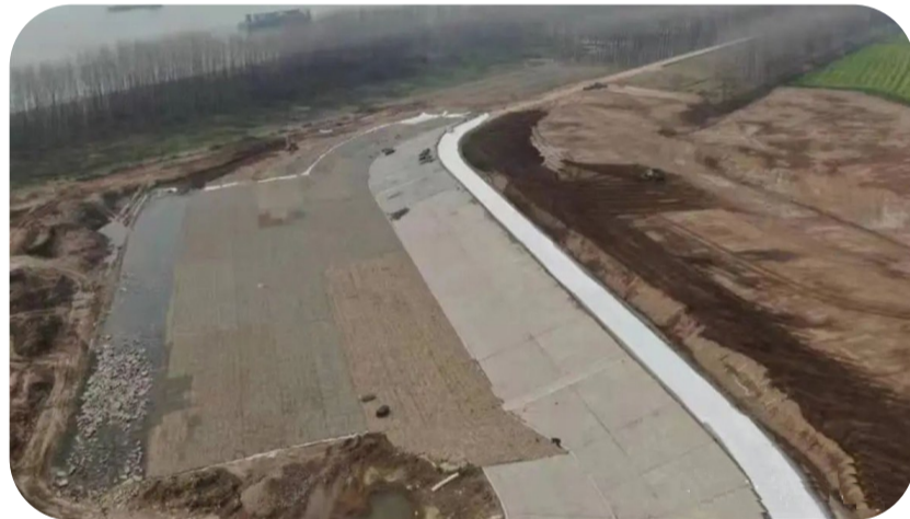
套口进洪闸正在进行左右岸堤顶公路的混凝土浇筑和养护。
