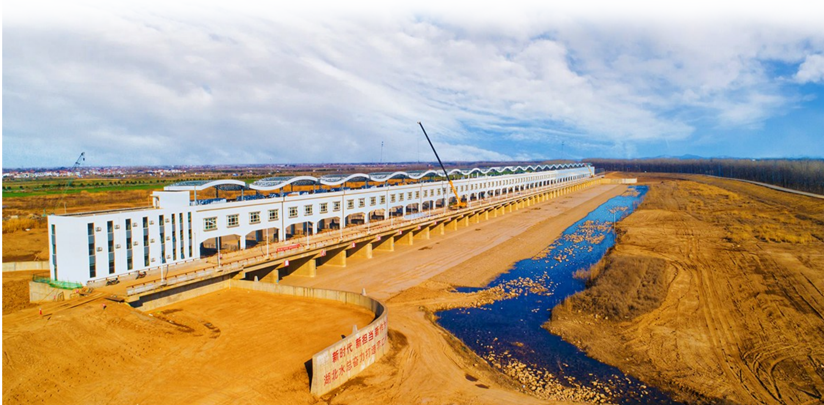
“长江干堤第一闸”——套口进洪闸
