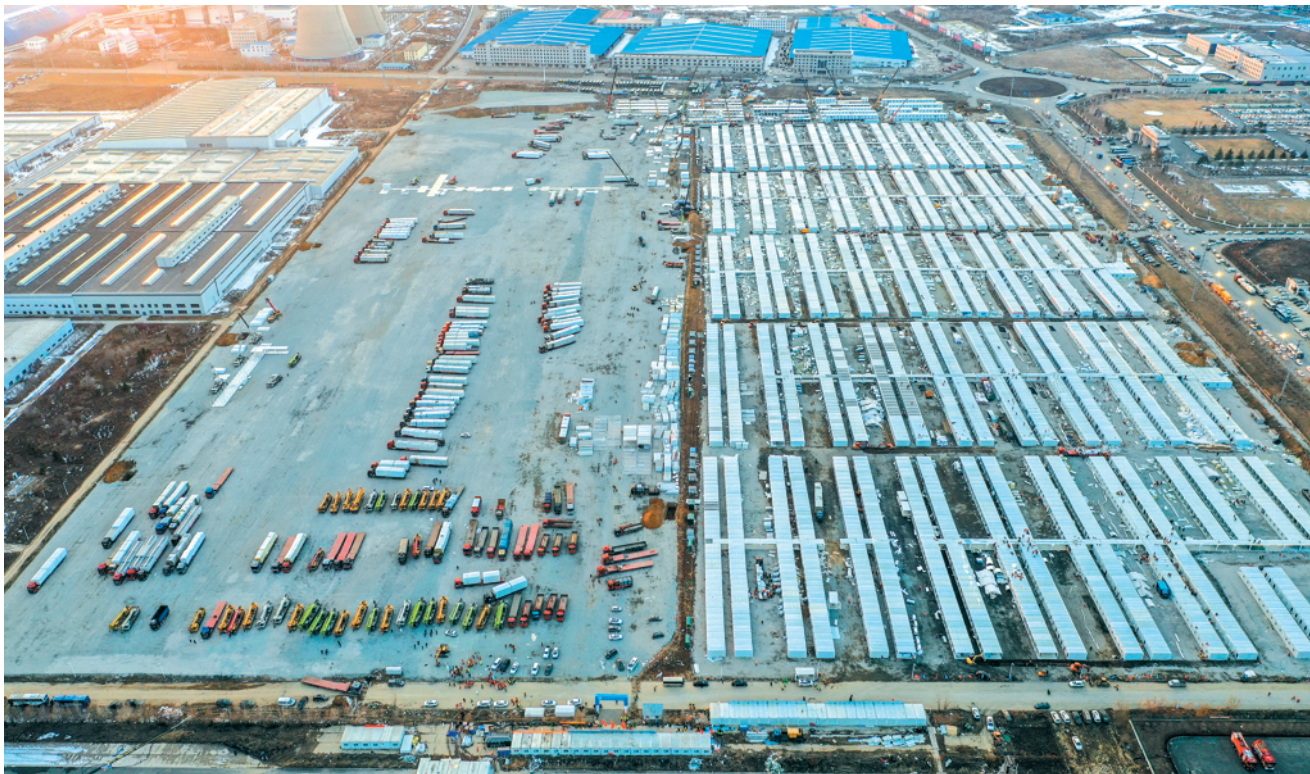
这是3月20日傍晚拍摄的吉林市高新南区隔离方舱建设现场(无人机照片)。3月20日,记者在吉林市高新南区隔离方舱建设现场看到,5000余名工人和百余台工程机械加班加点同时施工作业,为工程建设提速。
