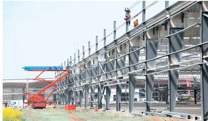
美的洗衣机产业园土建工程目前已基本结束,投产后将打造成全国最大冰箱全品类生产基地。
