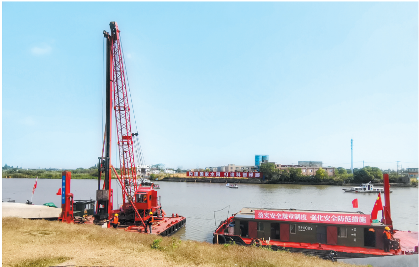
5月16日,在苏州昆山的吴淞江整治工程施工现场,工程船舶整装待发(手机拍摄)。(新华社发)
