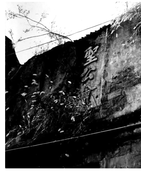
沔阳专区新堤中学(新堤圣公会校址)
