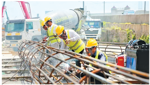
荆州复兴大道跨江汉运河桥工程建设现场
