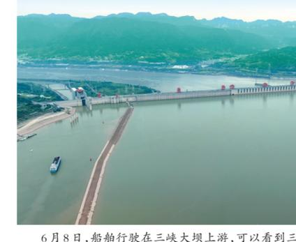
6月8日,船舶行驶在三峡大坝上游,可以看到三峡水库水位下降后的消落带。当日20时,实时水情显示,三峡水库水位已回落至145.78米,即将降至防洪限制水位145米。三峡水库本轮消落带从2021年11月11日起开始,以腾出防洪库容应对汛期长江流域可能发生的洪水,保障长江中下游地区的防洪安全。(新华社发)
