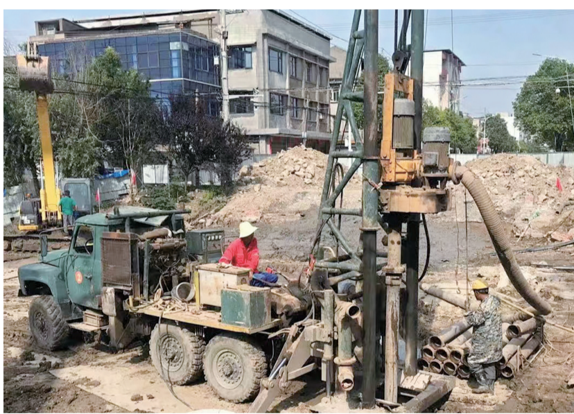
危桥改造项目施工现场。
