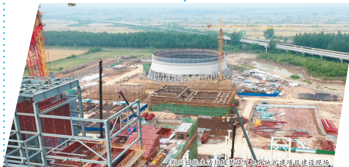
荆州旺能生活垃圾焚烧发电异地扩建项目建设现场
