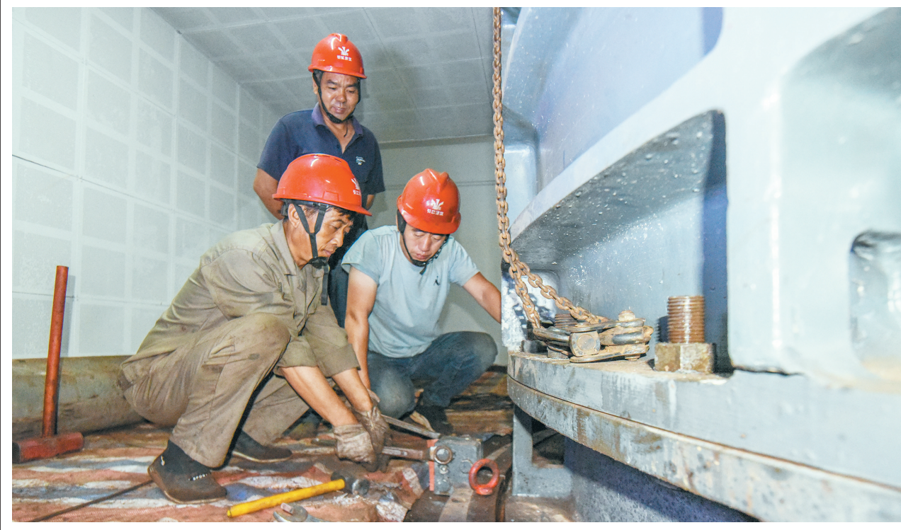
近日,湖北省引江济汉工程管理局荆州分局组织人员,对泵站机组进行全面检修,确保安全生产。 该局提前做好防汛抗洪预案,汛前全面排查隐患,组织开展抢险演练,并增派人手24小时巡查渠堤,实时监测与长江相连的入水口渠段水位情况,防患于未然。 (孙杨 冯广松 摄)
