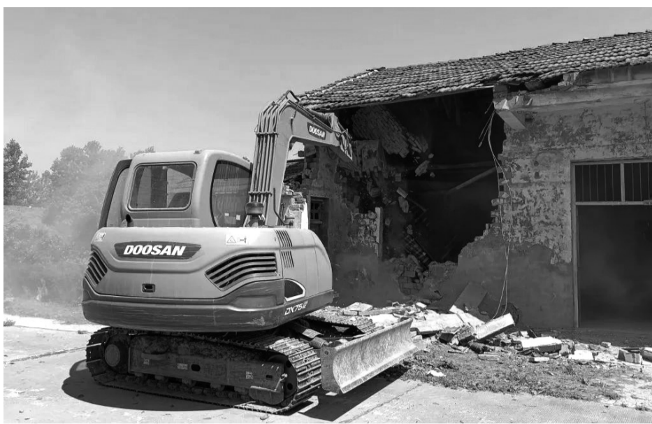
小河口镇清拆空心房、危房现场。(通讯员 刘栋然 摄)
