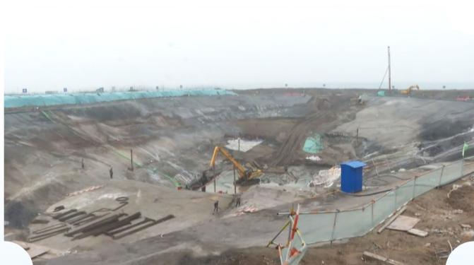
天鹅洲湿地恢复与保护项目(二期)天鹅洲泵站新建项目。
