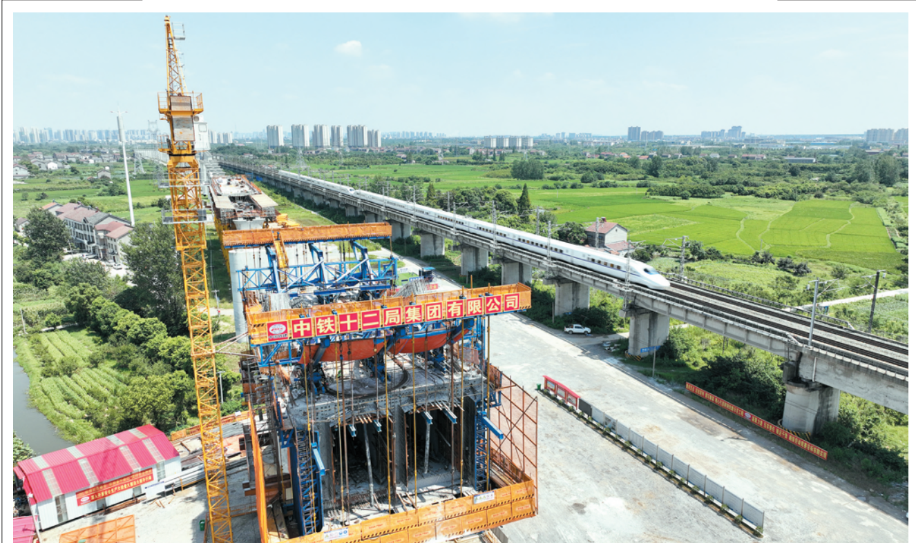
7月25日,荆荆铁路四标段中铁十二局集团跨江汉运河项目建设正酣,东岸箱梁已初具雏形。当前,荆荆铁路项目四标段桥涵工程已完成71%,路基工程已完成48%,铁路全线转入架梁、轨道铺设系统线上施工阶段。 (孙杨 郇欣 摄)
