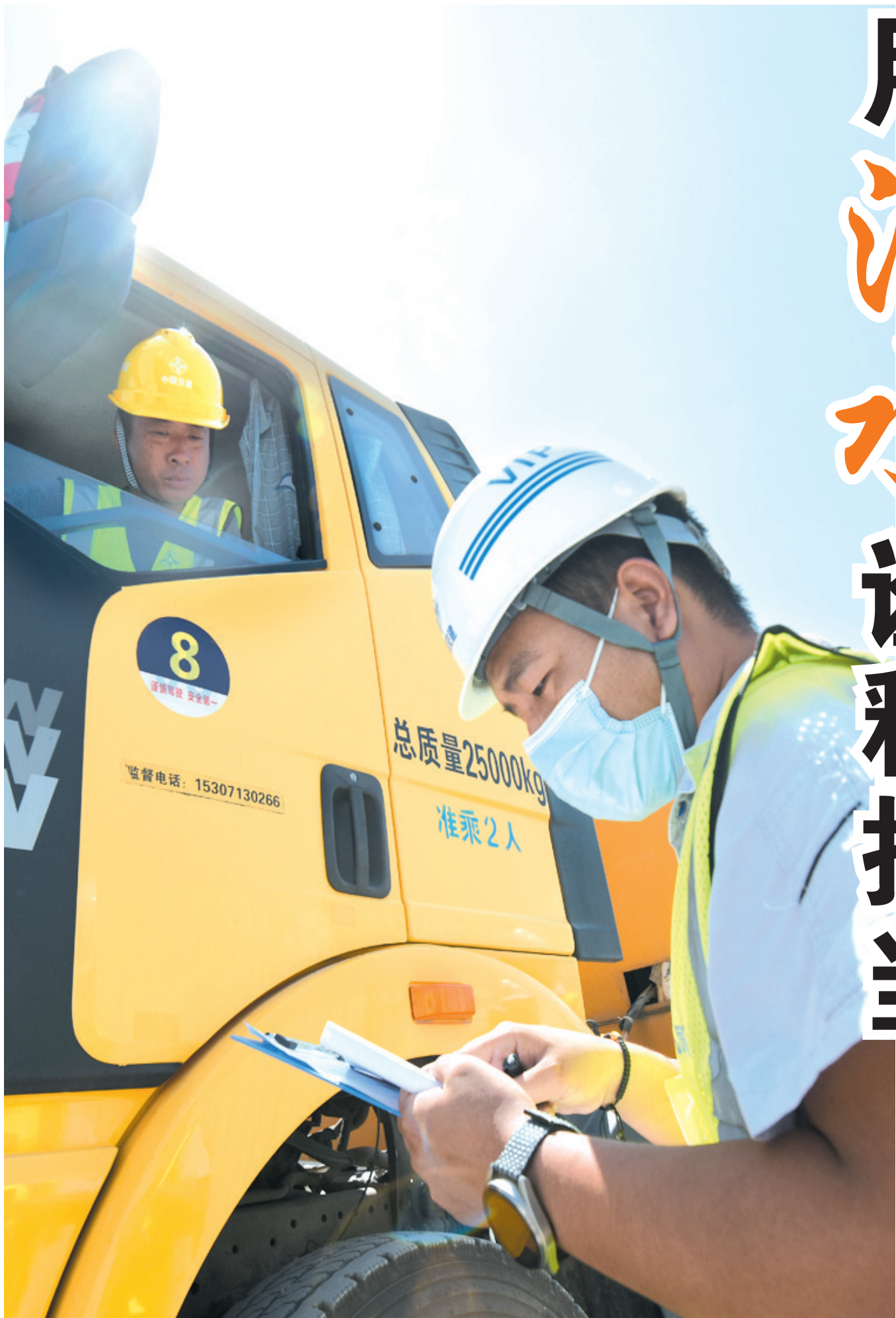
监利市周老嘴镇滩河口桥消危改造现场,安全员进行施工安全检查。
