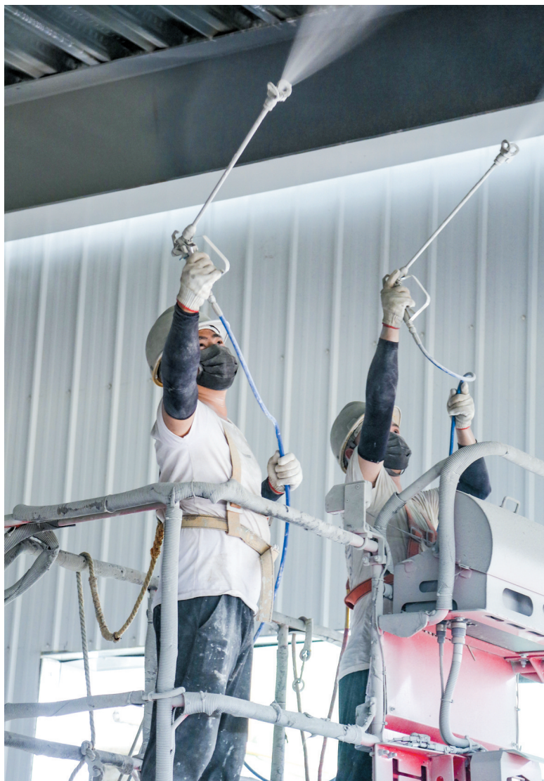
美的楼宇科技荆州产业园建设现场,工人加紧施工。
