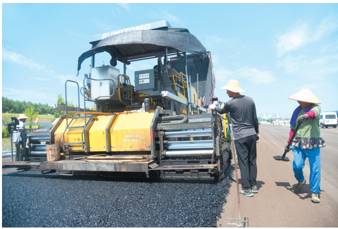
荆江大道(西环路—御河路)段,施工人员在烈日炎炎下,忙作业、赶工期。
