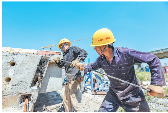
跨江汉运河特大桥项目6号桥墩建设现场,工人正在对预制梁穿插钢绞线,抓紧项目施工。
