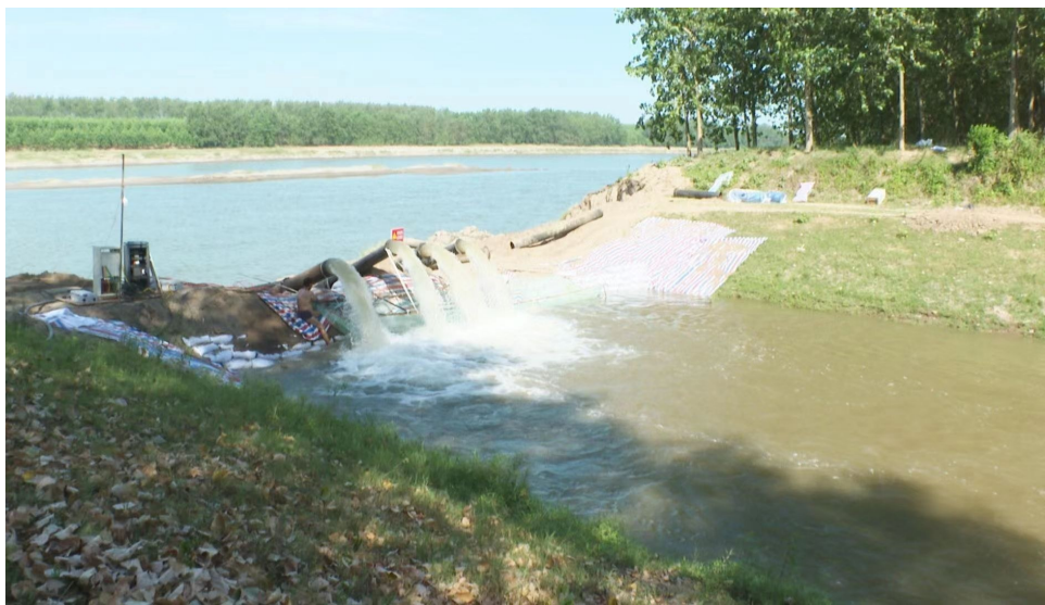
高庙集镇共计安装15台套潜水泵,抢引藕池河水,补充坑内抗旱水源。(记者 张红芳 通讯员 李倩 刘孟 摄)
